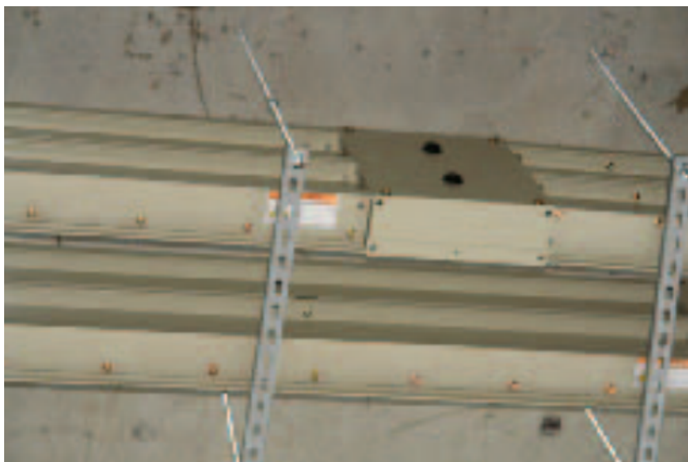
Рисунок 1.3 – Шинопровод марки LS Cable
