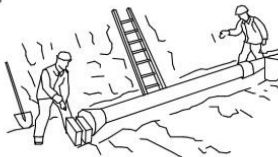
Монтаж с помощью натяжного приспособления
