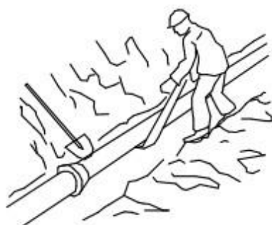
Подсыпка и трамбовка грунта
