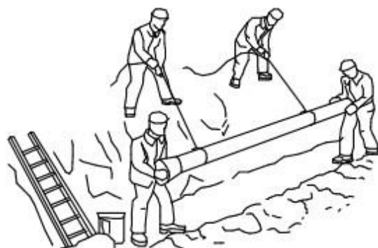
Спуск трубы в траншею
